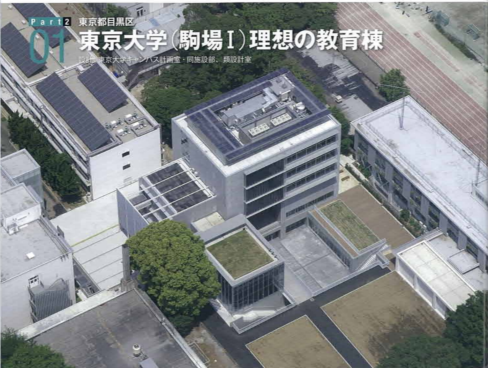
東京大学の駒場キャンパスに5月に竣工した。屋上には約30kWの太陽光発電パネルを設置した(この記事の写真: 類設計室)
