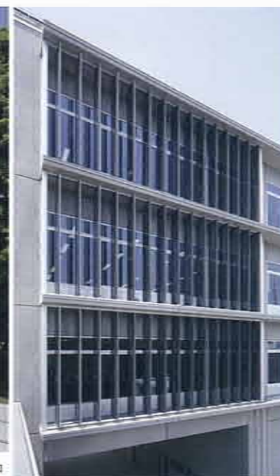
上はメインファサード 右が可動ルーバー。開け(右上) 閉め(右下)の制御には人工知能を使う。制御プログラムは、完成したものではなく、学生が参加し学生とともに最適な制御方法を学んでいく(資料: 類設計室)
