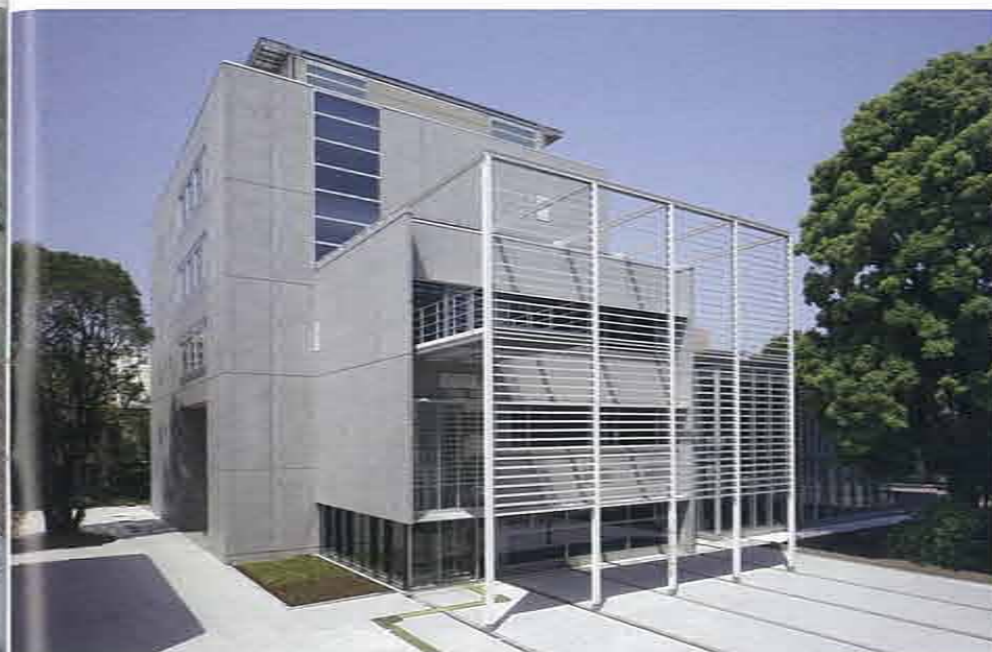
上はメインファサード 右が可動ルーバー。開け(右上) 閉め(右下)の制御には人工知能を使う。制御プログラムは、完成したものではなく、学生が参加し学生とともに最適な制御方法を学んでいく(資料: 類設計室)
